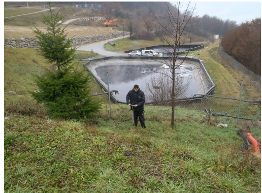
Prélèvement aval valorisation biogaz
